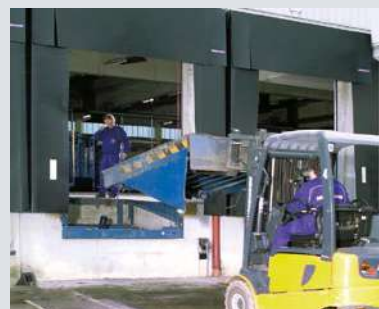
Демонтировать старый перегрузочный мост, при необходимости компенсировать размеры приямка (например, с помощью монтажных пластин или консолей)
